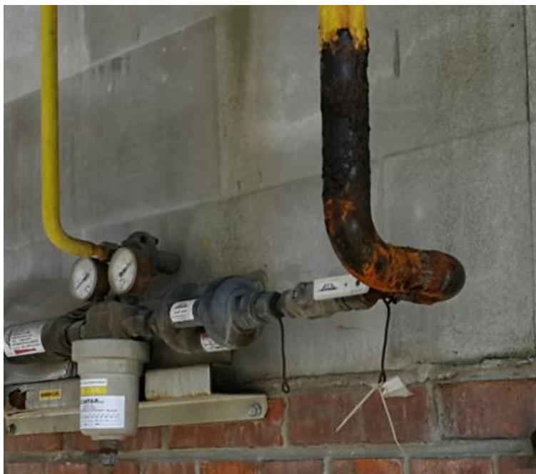
Slika 3; SV-8A za red. ventilom v plinski postaji acetilena. Zaščita pred samorazkrojem.
